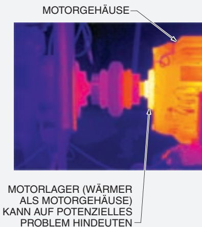
Abbildung 2-2. Wenn ein Motorlager erheblich wärmer als das Motorgehäuse ist, deutet das auf mögliche Schmierungs- oder Ausrichtungsprobleme hin.
