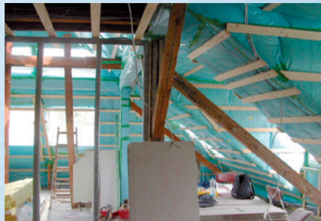
Die BlowerDoor Messung zur Qualitätssicherung während der Bauphase
