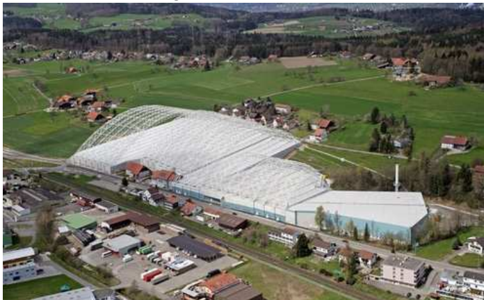
Luftaufnahme der Rückbauhalle (Quelle: SMDK)
