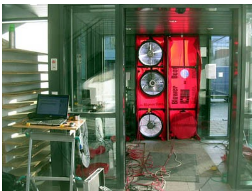
Mesures avec BlowerDoor dans un grand bâtiment
