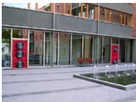
Mesure avec 5 ventilateurs BlowerDoor
